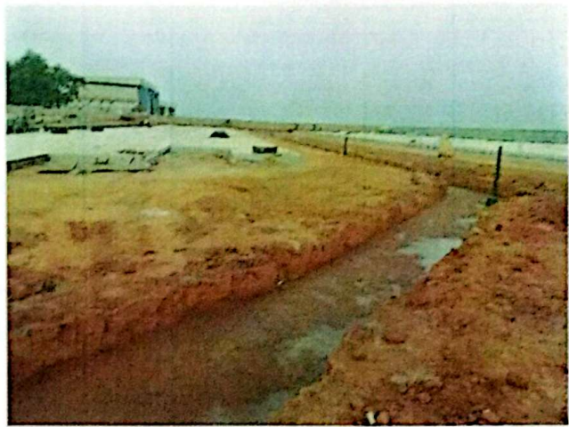
Vue phase de remblaiement
