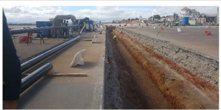
Travaux de soudure des pipelines
