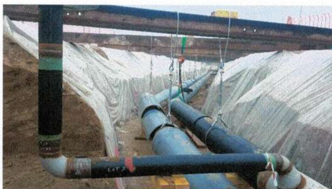
Basculement des conduites pour remplacement de la seconde conduite
