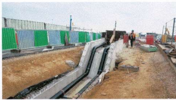
Construction du caniveau et pose des conduites
