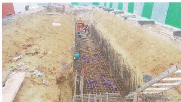
Travaux de construction du caniveau technique
