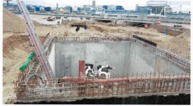
Travaux de remblaiement
