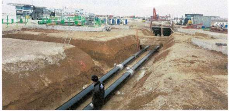
Pose des conduites et réalisation chambre
