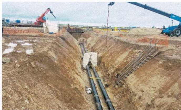
Pose des conduites
