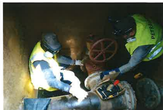
Pose d'une DBB 10' sur réseau en service
