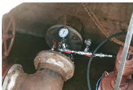
Mise en pression de l'hydrant à remettre en service
