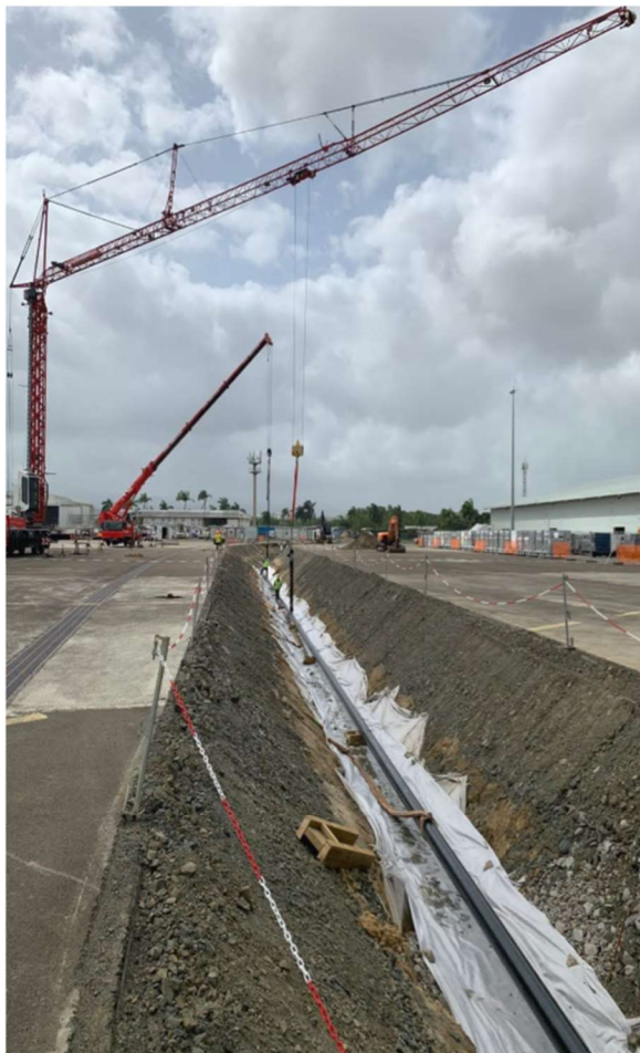
Travaux de levage des pipelines
