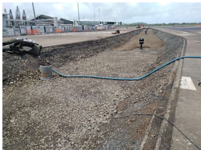
Travaux de remblaiement
