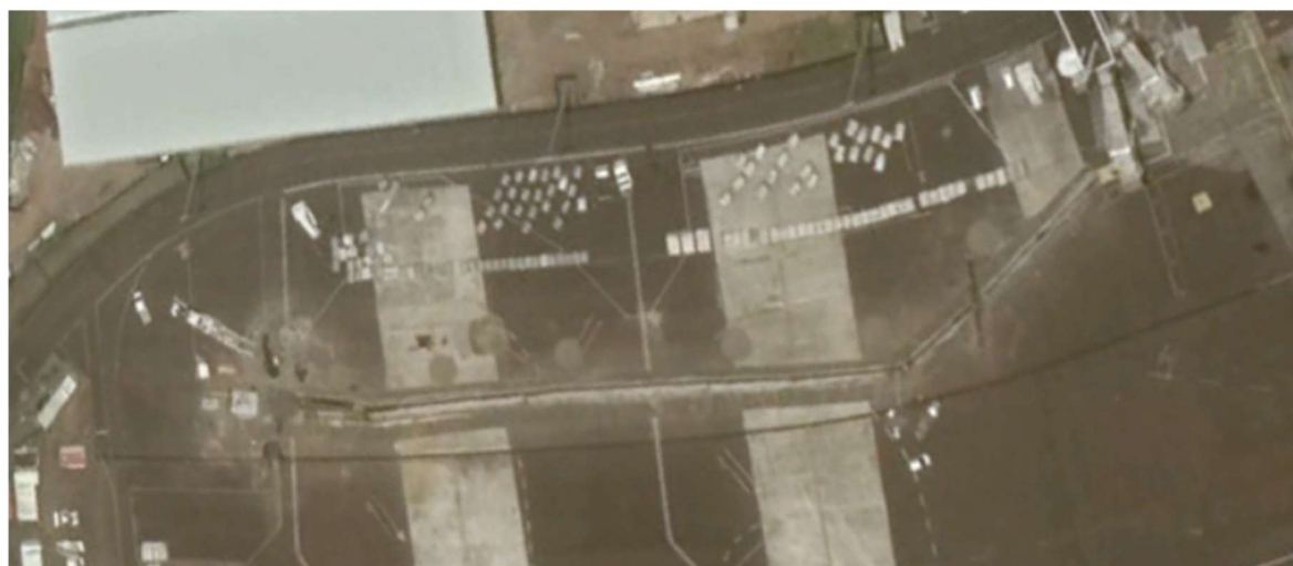
Vue aérienne des travaux
