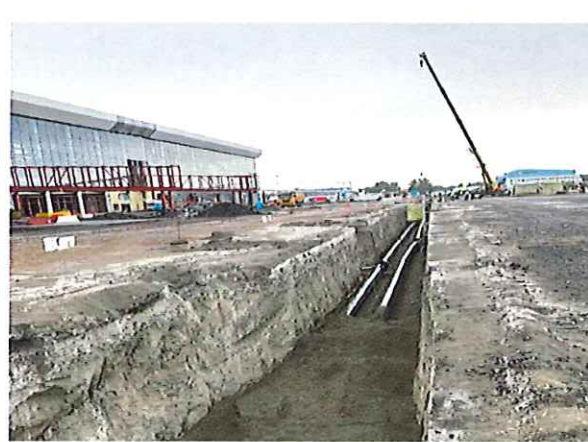
Construction de l'hydrant (Crédits photos TOTALENERGIES)
